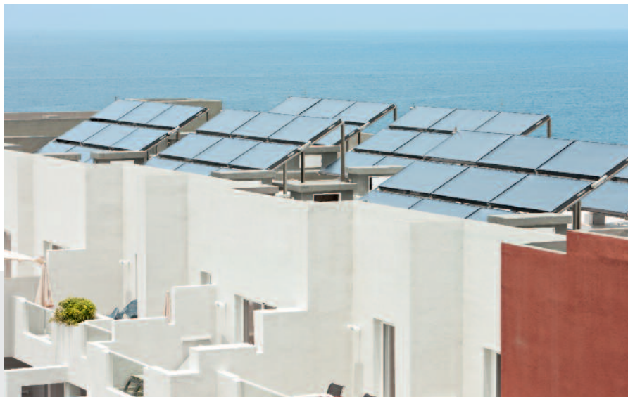
Hotel mit Photovoltaikanlage auf Teneriffa
